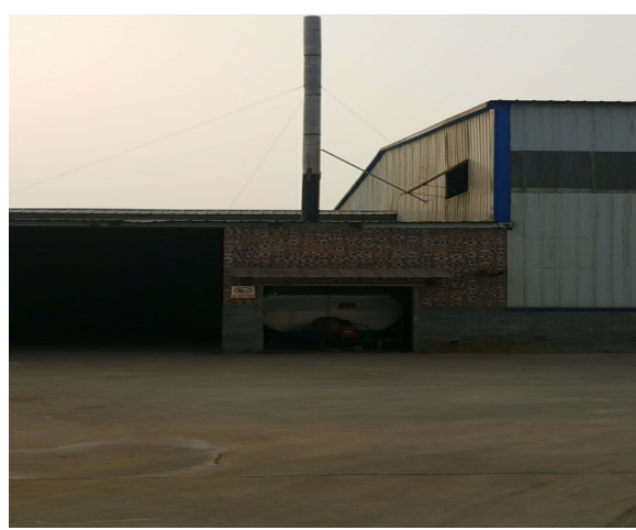
附图6锅炉排气筒
